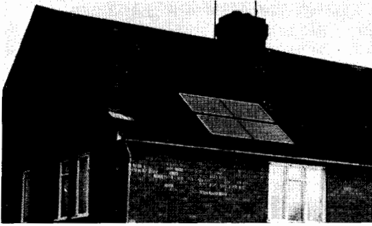
Paneles solares en cubierta
