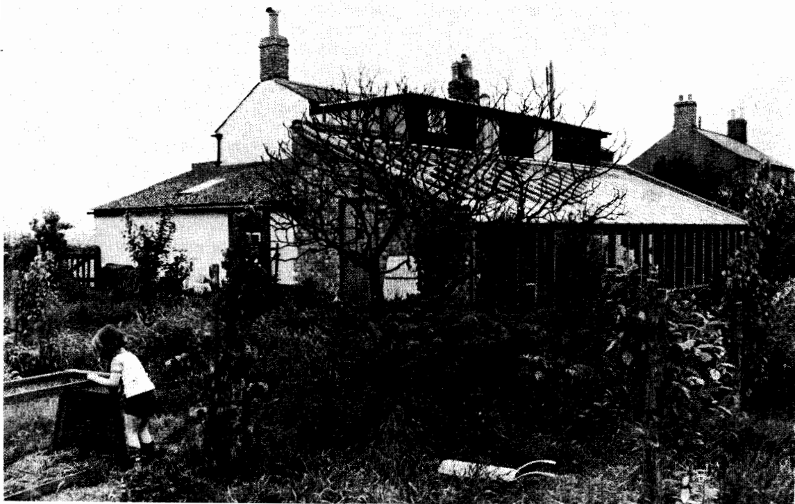
Ganancias solares pasivas en una ventana orientada al sur (arriba) y un invernadero (abajo)
