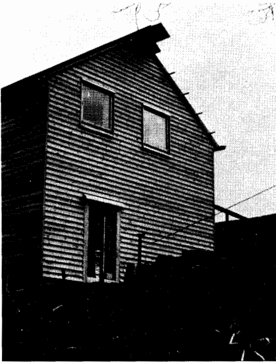
Aislamiento exterior revestido de madera
